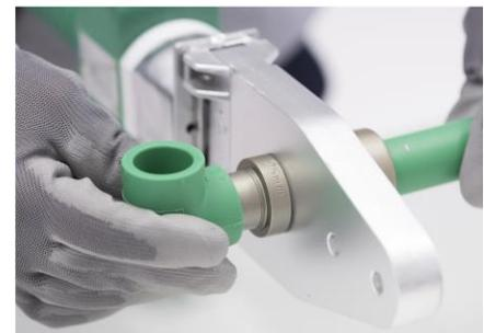
Transcurrido el tiempo necesario, se sacan las matrices y se introduce el tubo dentro del accesorio, manteniendo la presión. Este tipo de soldadura garantiza una unión perfecta tubo –accesorio, con lo que se elimina el riesgo de fugas.
